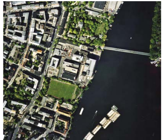
Das Gelände der Schultheiß-Brauerei 1989 (© Wasserstadt GmbH)
