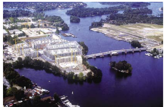
Das Quartier Siemensspitze im Bau und das Quartier Haveleck, bei dem gerade die alten Öllager entfernt werden (© Wasserstadt GmbH)
