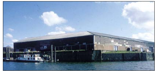
Leer stehende Gebäude und Schuppen am Magdeburger Hafen/Baakenhafen
