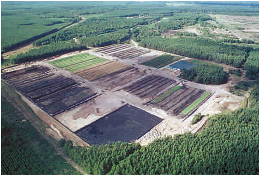
Die Faulschlämme werden getrocknet und dann entsorgt (© Fotograf: Henrik Pohl)
