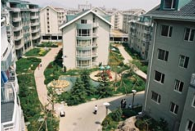
Neue Wohnsiedlung mit grosszügigen Grundrissen und Grünanlagen. Die Wohnungen im Erdgeschoss haben einen eigenen kleinen Garten. Auch dies ist eine abgeschlossene Siedlung, die man nur durch ein Tor betreten kann.
