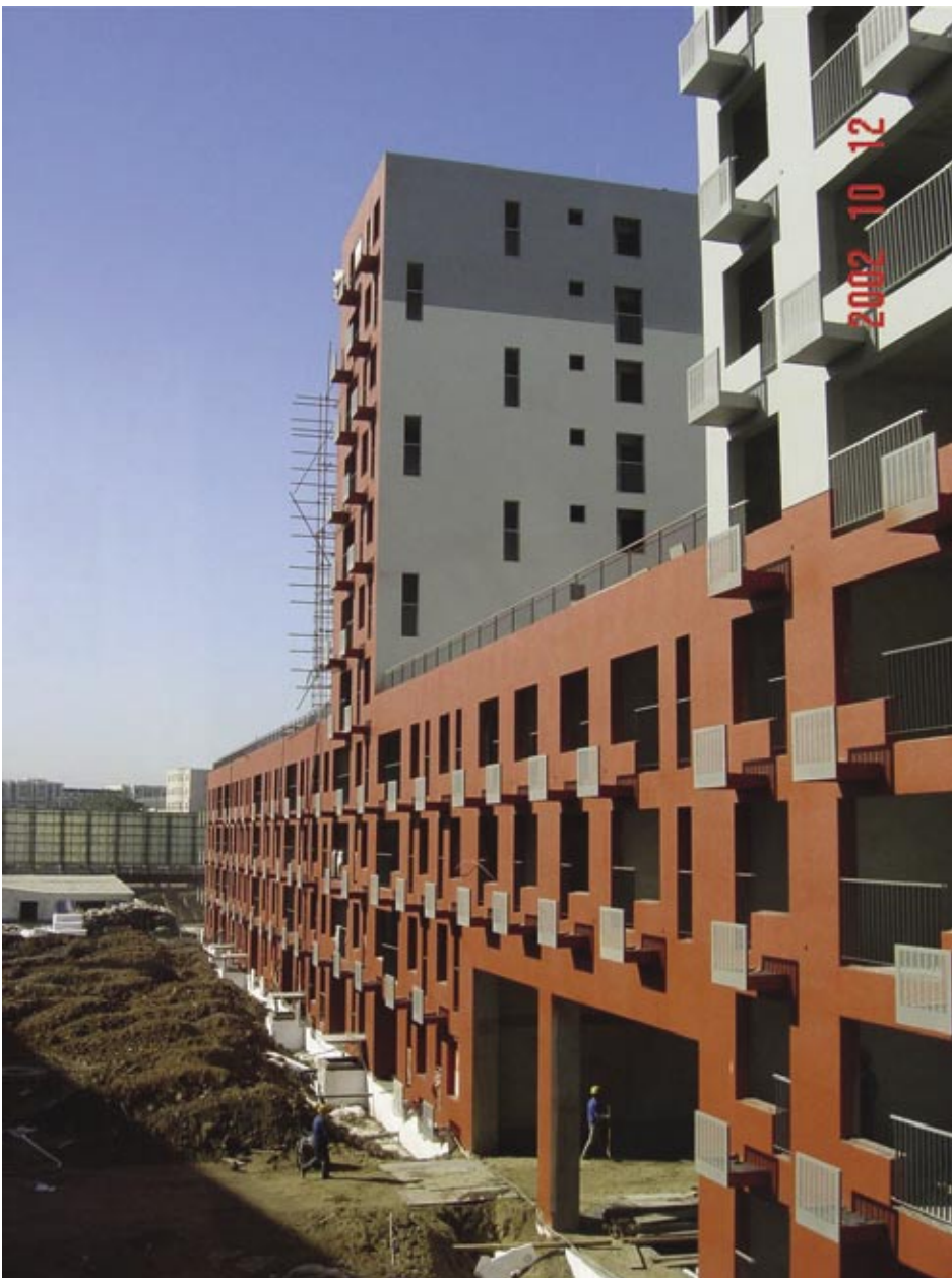
配有阳台与空调的楼面
