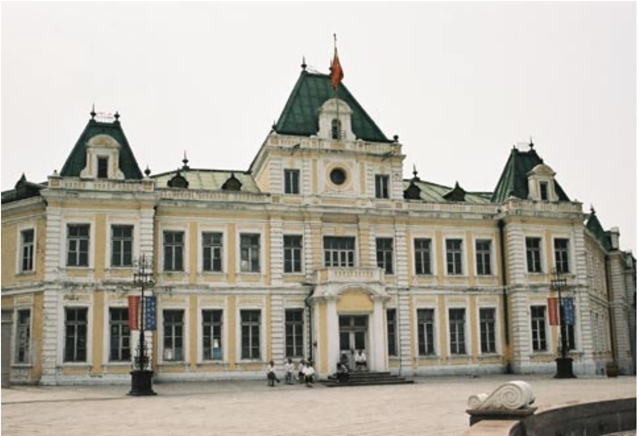
Koloniale Überbleibsel: Haus aus der russischen Einflussphase
