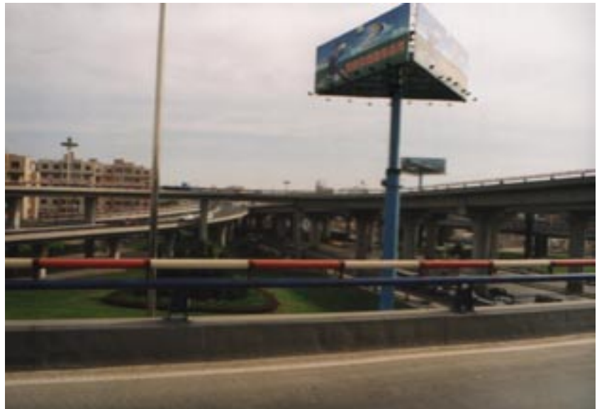
Dreistöckige Straßenkreuzung in Dalian (Foto: H.-J. Becker)
