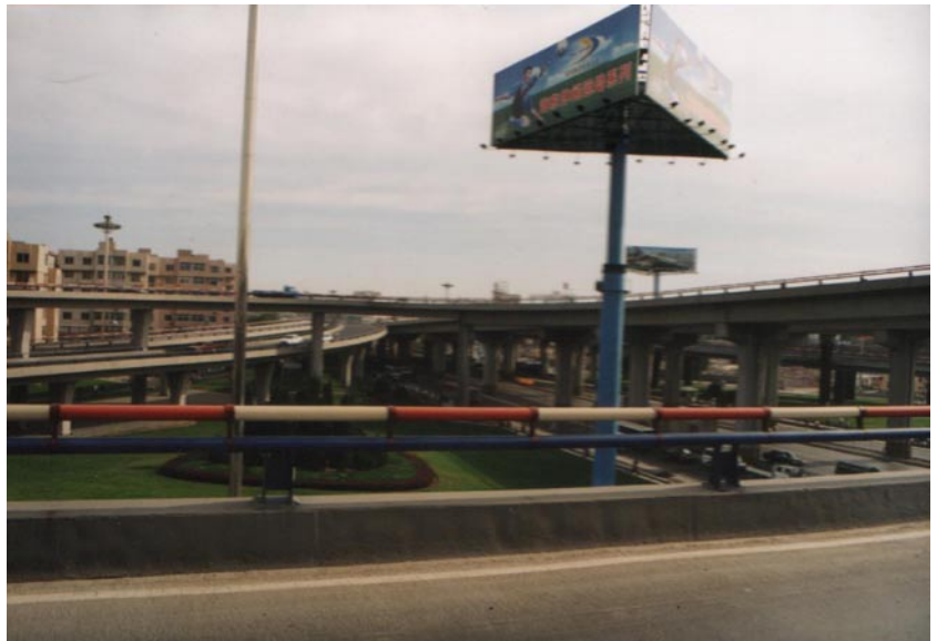
大连的三层立交桥（摄影：H.-J. Becker）
