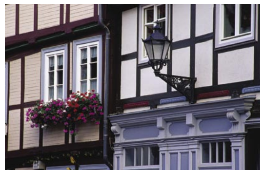
Fachwerk in Quedlinburg
