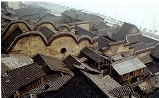
Brandschutzmauern in Drachenform
