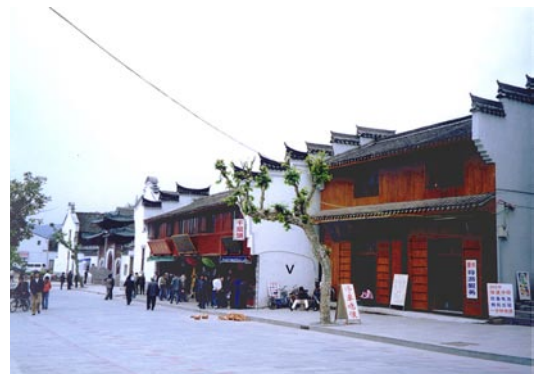
Straßenansicht nach erfolgter Rekonstruktion
