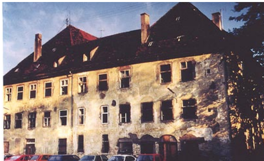
Waisenhaus: Nordfassade vor dem Umbau
