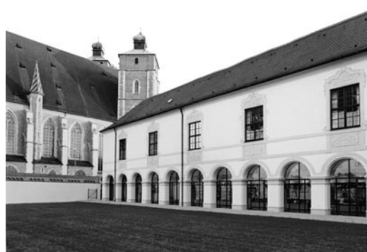
Ehemaliges Jesuitenkolleg: Ostfassade nach dem Umbau
