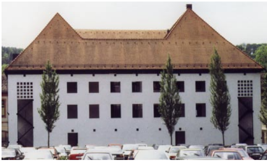
Waisenhaus: Nordfassade nach dem Umbau
